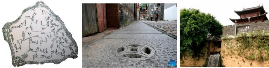
Figura 16 a 18. Comporta de equilíbrio hídrico localizada nos muros da cidade, antiga vala de drenagem na calçada urbana e planta do sistema de drenagem de Fushougou, elaborada na Dinastia Qing. Fonte: Xinhua (2025). Disponível em: https://en.people.cn/n3/2025/0710/c90000-20338332.html . Acesso em: 5 de abril de 2026.
