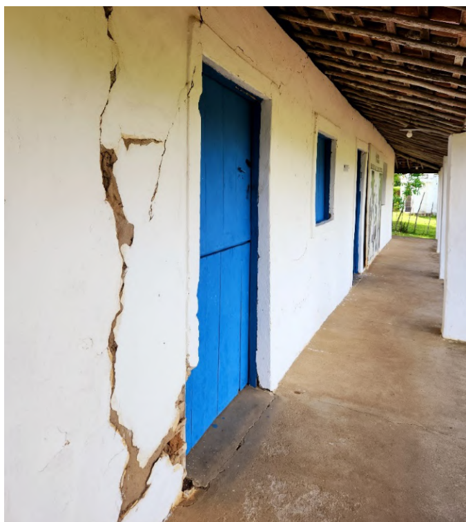
Figura 5. Fachada lateral do MLLC, com destaque para rachaduras na parede. Foto do autor, 2025.
