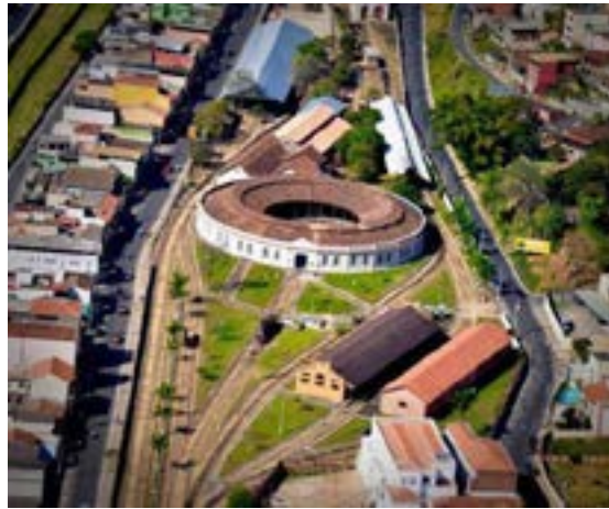
Figura 09 – Vista aérea do pátio ferroviário com a rotunda ao centro. Ano: 2013.
