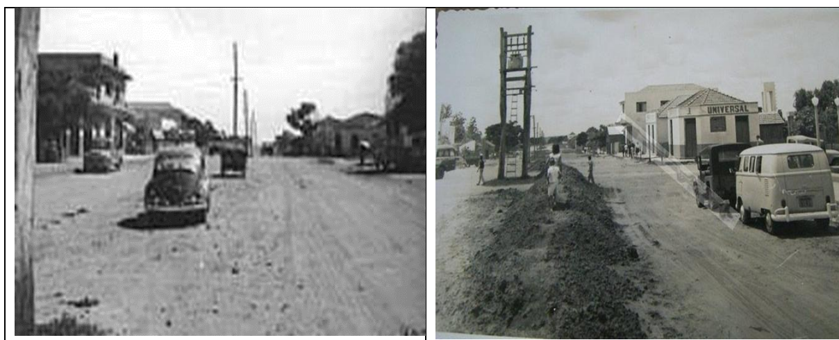
Imagem 3 e 4. Avenida Pedro Manvailer com postes de madeira e transformador de energia
